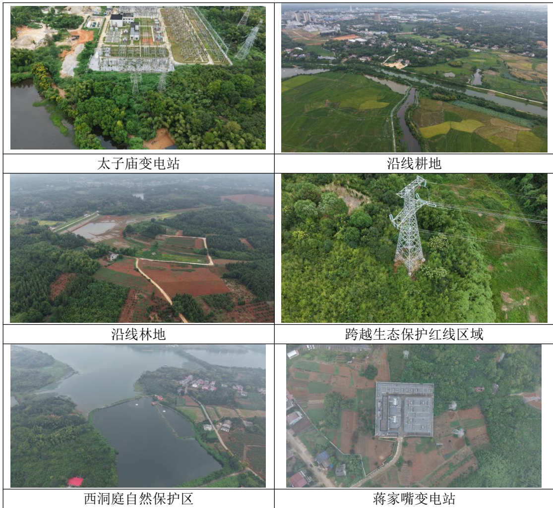
图 9 本工程环境现状
