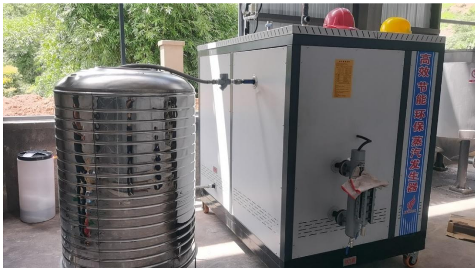
图 2-12 蒸汽发生器示意图
