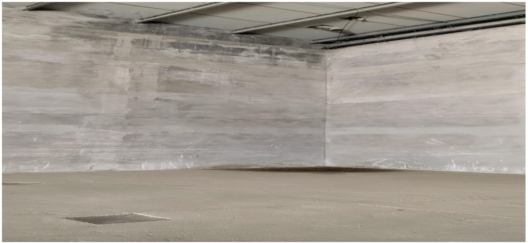
成品输送管道落料口现状照片
