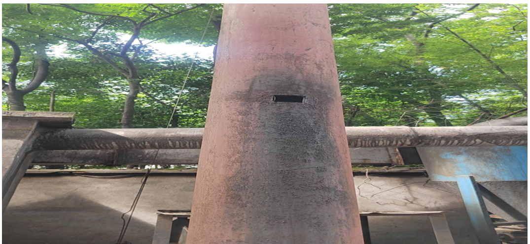
锅炉废气排气筒采样口现状照片
