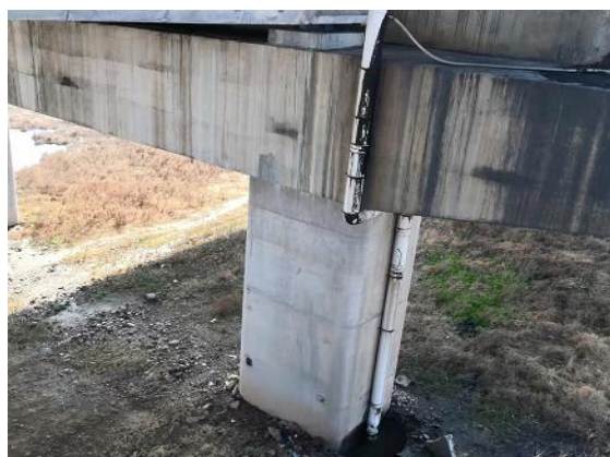
沅水四桥无事故应急池，桥面径流直排沅江
